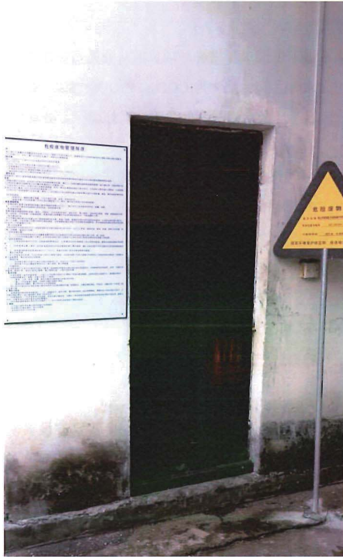
图 5-2 危险废物暂存点
